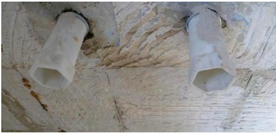
Typische Schäden bei nicht sauber ausgeführten Abdichtarbeiten
